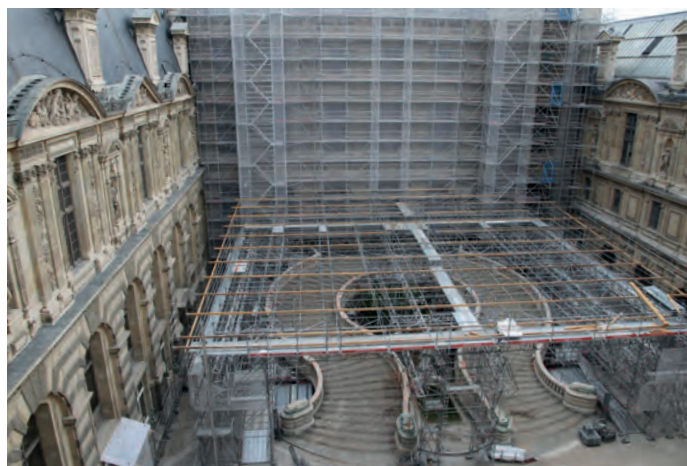
Chantier dans la cour Lefuel
